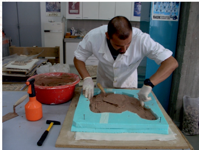
Τοποθέτηση του νέου κονιάματος. Applying new mortar.
