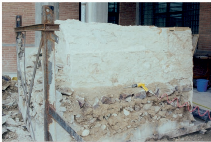
Σταδιακή απομάκρυνση μέρους της τοιχοδομής. Gradual removal of a part of the wall structure.
