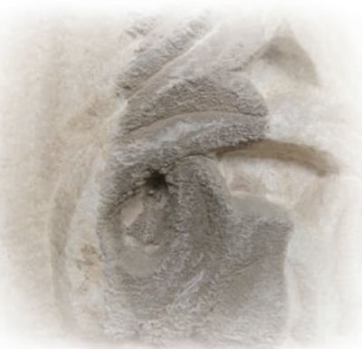
Λεπτομέρεια από κιονόκρανο. Διακρίνεται μαύρη κρούστα, που δημιουργείται από τους αέριους ρύπους του αστικού περιβάλλοντος.
