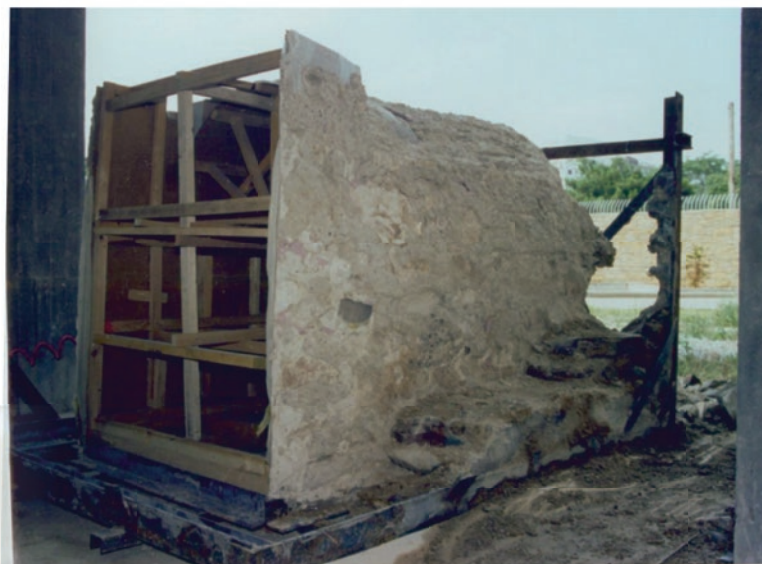
Ολοκλήρωση της απομάκρυνσης μέρους της τοιχοδομής και αποκάλυψη του υποστρώματος των τοιχογραφιών.
