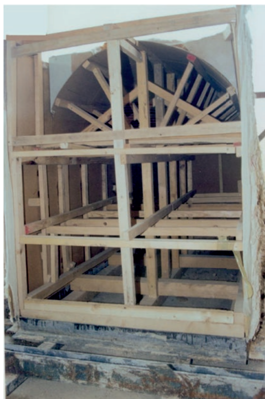
Ξύλινο υποστήριγμα -εσωτερικά του τάφου- για την προστασία των τοιχογραφιών κατά την απόσπαση και μεταφορά του.
