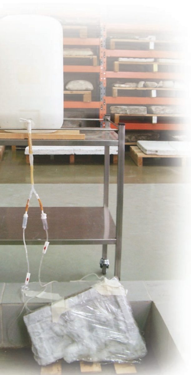
Στερέωση της σαθρής επιφάνειας του μαρμάρου με υδροξείδιο του βαρίου. Consolidating the weak surface of the marble using barium hydroxide.
